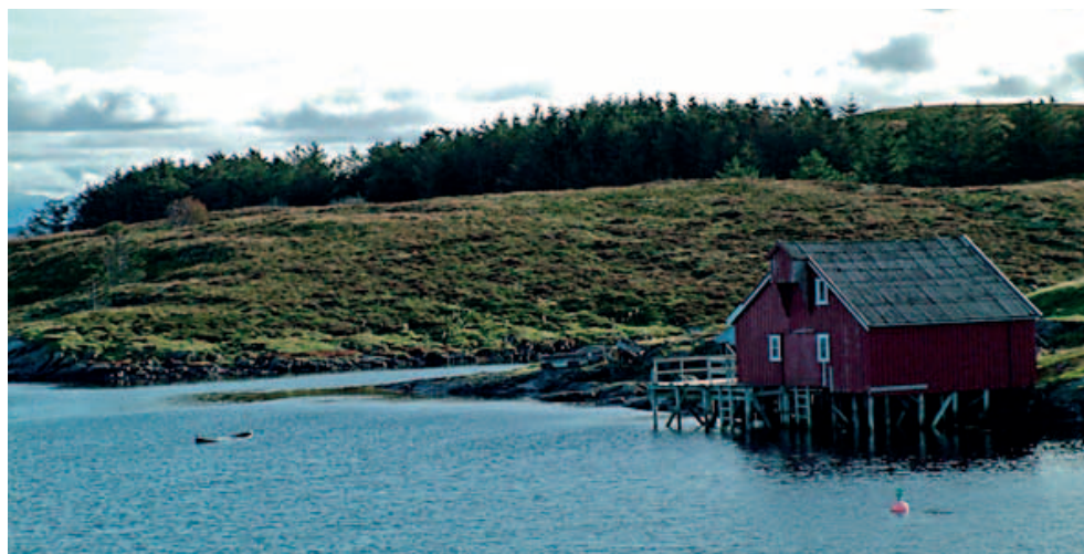
Bilde 10: Sjøhusenes nærhet til vann begrenser naturligvis effekten av gjengroing, men det er viktig å tenke på at disse bygningene også har en rolle i landskapet sett fra land. Foto: W. Dramstad.
